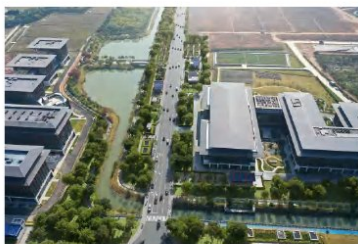
广州地铁： 广州市轨道交通8号线 东延段工程总承包——敦辉
