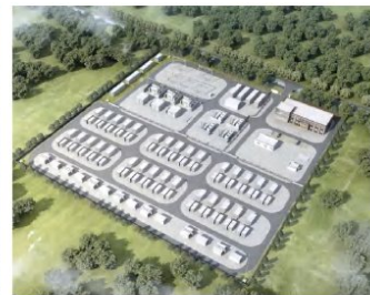
山东电力咨询院： 国电投临清51.875万千瓦风电项目
