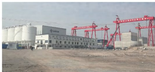
中交三航局： 大洋山海工基地项目
