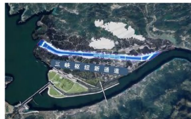
水电四局： 三峡水运新通道先行开挖区施工项目
